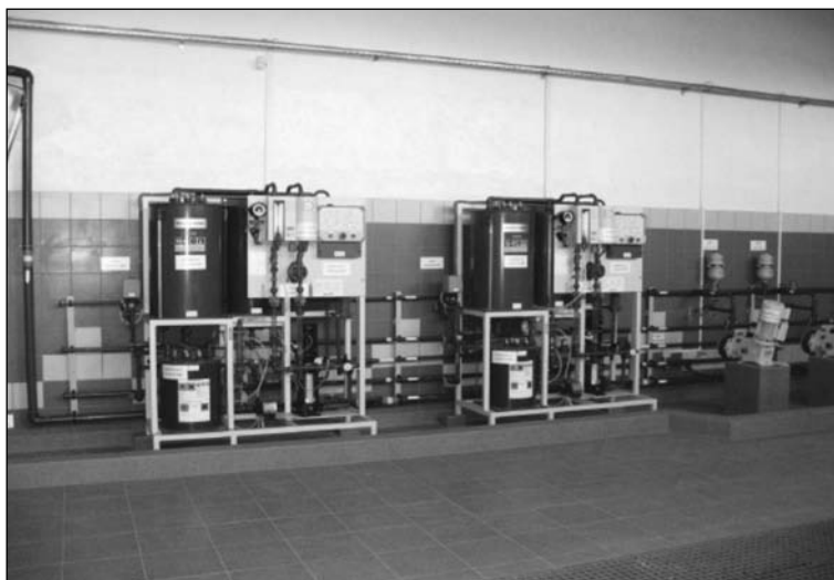
Rys. 5. Instalacja wytwarzania \text{ClO}_2 – końcowa dezynfekcja.
