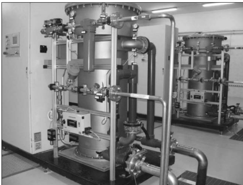
Rys. 3. Generatory wytwarzania ozonu.
